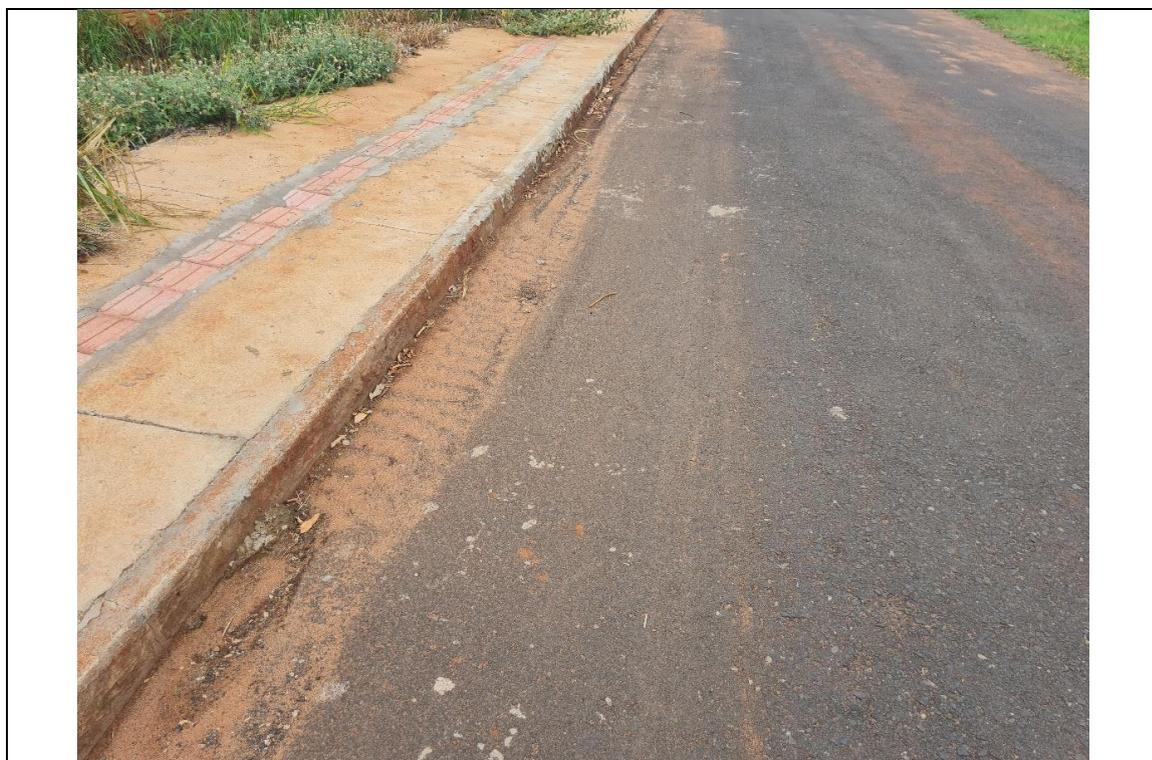
**FOTO 04 – AV. PARANÁ:** Execução do revestimento em CBUQ.
