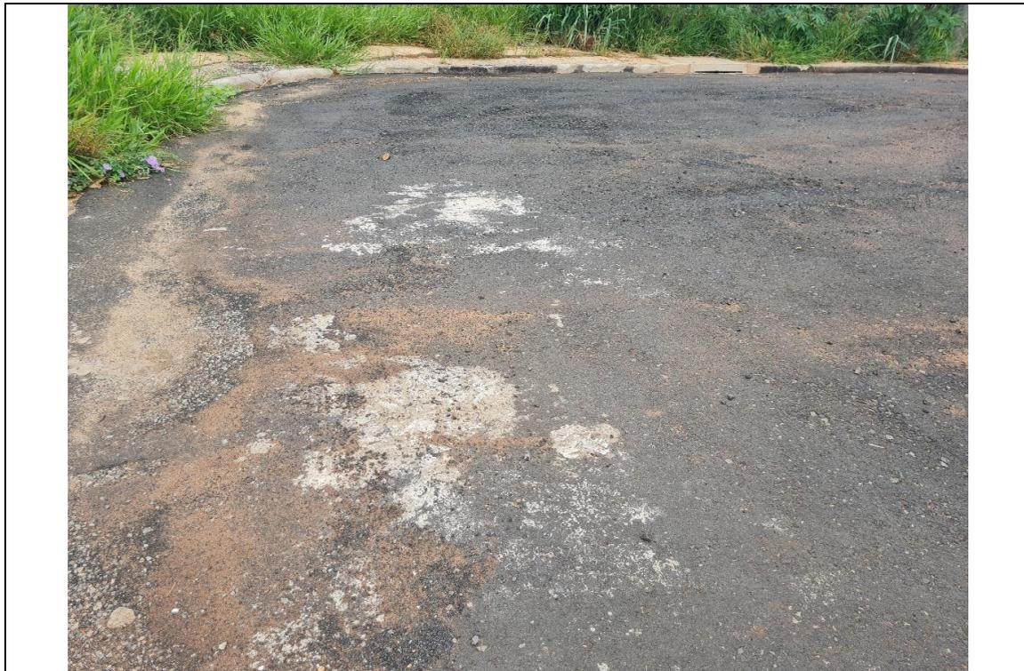
**FOTO 14 – AV. PARANÁ x RUA ALEMANHA:** Execução do revestimento em CBUQ.
