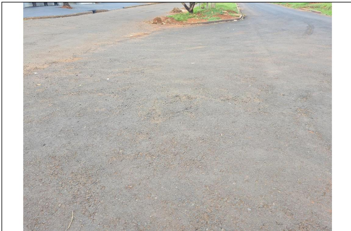
**FOTO 12 – AV. PARANÁ:** Execução do revestimento em CBUQ.
