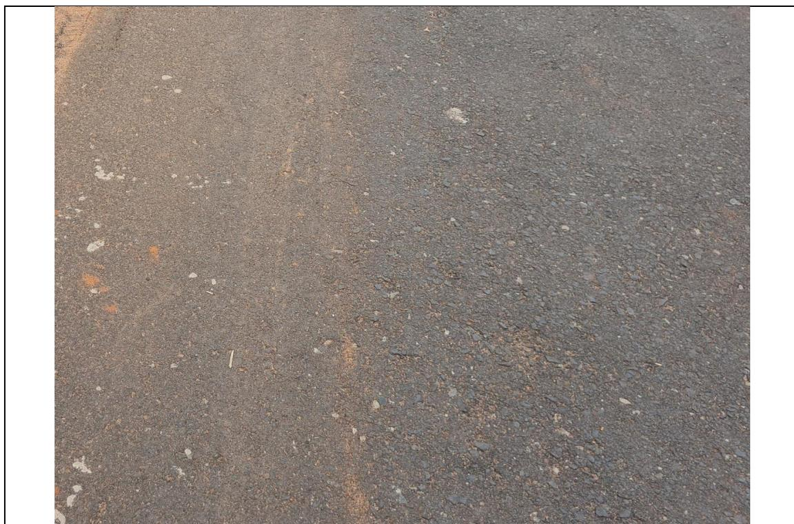
**FOTO 03 – AV. PARANÁ:** Execução do revestimento em CBUQ.
